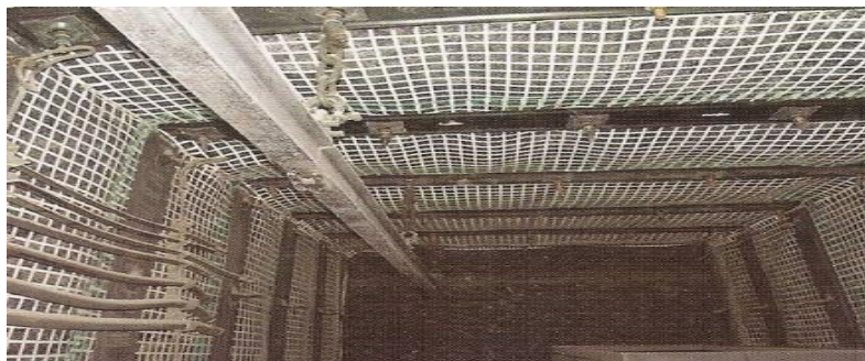
Рисунок 1 – Использование полимерной сетки в подготовительной выработке
