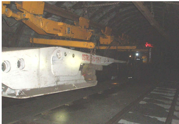
Рисунок 1 – Транспортування секцій механізованого кріплення у нерозібраному стані, шахта «Степова» ПАТ «ДТЕК Павлоградвугілля»
