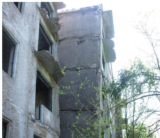
Рисунок 3 – Деформація п'ятиповерхових будинків
