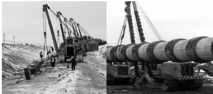
Рисунок 1 – Укладання трубопроводу та його баластування спеціальними вантажами в зимових умовах
