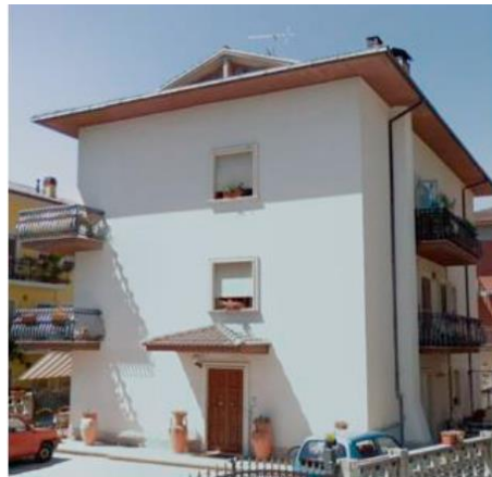
Рисунок 2 – Будівля в муніципалітеті Аквілі, Італія [3]
