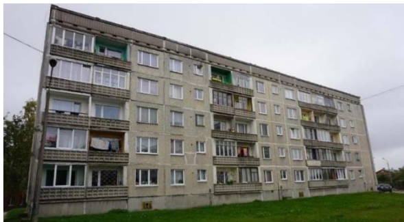
Рисунок 1 – Будівля старого житлового фонду з фасадними тріщинами [1]
